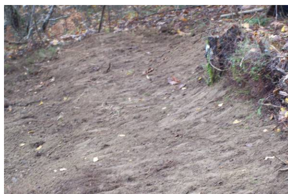
Drenaggio idraulico a monte della Roccia 2
