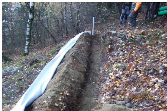
Drenaggio idraulico a monte della Roccia 2
