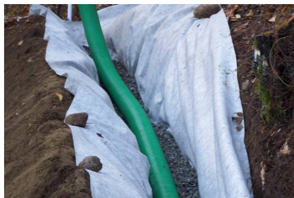
Drenaggio idraulico a monte della Roccia 2
