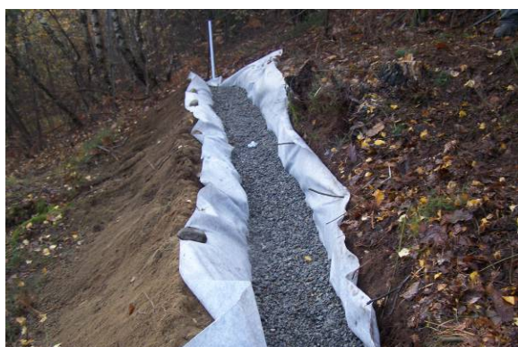
Drenaggio idraulico a monte della Roccia 2
